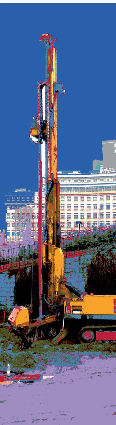
La perforatrice per micropali, chiamata anche sonda di perforazione o trivellatrice, è dotata di numerosi elementi che la rendono una macchina complessa; con la perforatrice è possibile eseguire fori di vario diametro (in genere dai 10 ai 20 cm) per il successivo inserimento del tubo che, insieme al getto di malta cementizia, costituisce il palo di fondazione.
